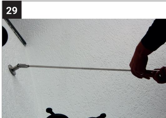
Schrauben Sie die Zugstäbe bis zur Hälfte des Rechtsgewindes in die oberen Wandhalter und ebenfalls bis zur Hälfte des Linksgewindes in das Glashalter-Gelenk.
