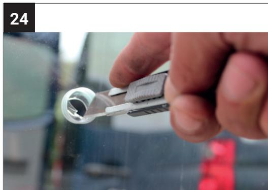
Schneiden Sie eventuell bei der Glasproduktion entstandene VSG-Folienreste mit einem Cutter ab.
