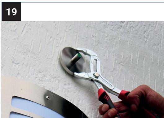
Schrauben Sie die Wandteller mit einer Greifzange auf die Gewindestangen.
