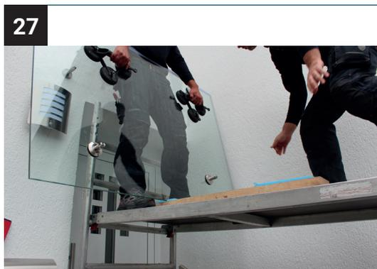
Heben Sie das Glas mit Hilfe von Glas-saugern so aufs Gerüst, dass die Glasunterseite zur Wand hin zeigt.
