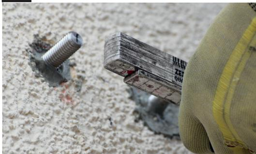
Überprüfen Sie während der Aushärtezeit noch einmal die Abstände der Gewindestangen und richten Sie ggfs. die Stangen passend aus.
