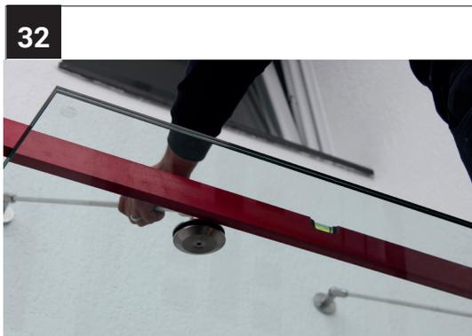
Justieren Sie die Zugstäbe parallel und richten Sie das Vordach mit Hilfe der Wasserwaage aus. Achten Sie besonders darauf, dass Sie die Zugstrebe nicht raus drehen und das Glas damit runter klappt.
