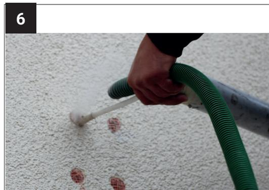
Entfernen Sie den Bohrstaub mit einer Luftpumpe aus den Bohrlöchern. Das sorgt für einen verbesserten Haftverbund.
