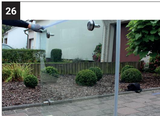
Die Glashalter-Stege für die Zugstreben-Befestigung sind zur Oberseite ausgerichtet und die Glashalter-Stege für die Wand-Glas-Halter zeigen zur Unterseite.
