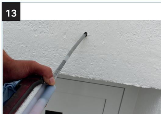
Verwenden Sie einen auf Ihren Untergrund abgestimmten Kleber und beachten die Herstellerangaben. Führen Sie die Kanüle in das Bohrloch und drücken den Kleber gleichmäßig aus der Kartusche. Ziehen Sie die Kanüle dabei langsam aus dem Bohrloch.
