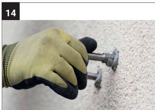
Ziehen Sie die Gewindestangen heraus und füllen Sie den Kleber gleichmäßig ins Bohrloch. Schieben Sie dann die Gewindestangen drehend wieder ins Bohrloch.
