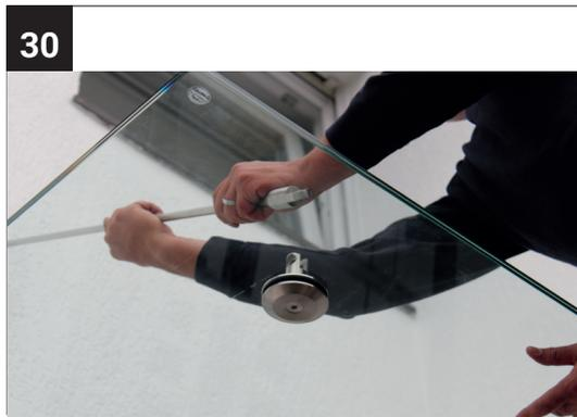
Klappen Sie das Glas hoch, bis Sie mit den vorderen Glashaltern die Zugstäbe erreichen. Schrauben Sie die Gelenke der Zugstäbe mit dem Inbusschlüssel an die vorderen Glashalter.
