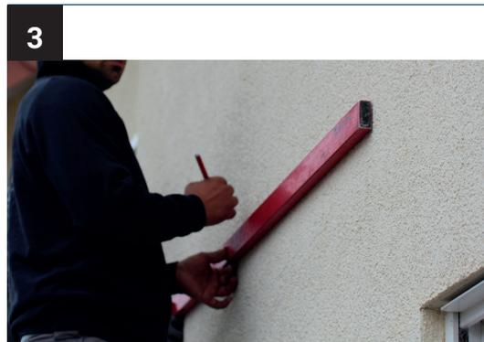
Ermitteln Sie die Haustürmitte und zeichnen ca. 20 cm über dem Türrahmen einen ersten Basispunkt an. Richten Sie hier die Wasserwaage aus und zeichnen eine Basislinie an.
