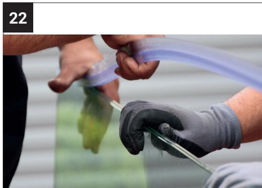
Sofern Sie eine Wandanschluss-Dichtung verwenden, schieben Sie diese nun aufs Glas. Beachten Sie, dass die Lippe nach oben zeigt.
