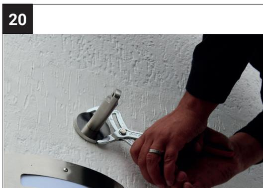
Schrauben Sie zuerst das untere und dann das obere Verbindungsgelenk des Glashalters an.
