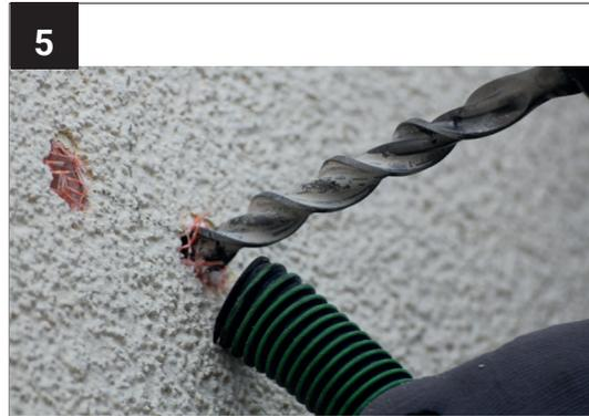
Verwenden Sie den zum Befestigungsmaterial passenden Bohrer. Saugen Sie beim Bohren den Bohrstaub ab.
