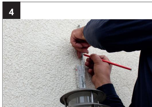
Zeichnen Sie gemäß der Angaben in Ihrer technischen Zeichnung die Bohrlöcher für die unteren Glashalter und die oberen Stange-Wand-Halter an.
