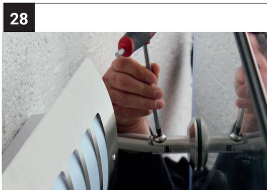
Verschrauben Sie das Verbindungsgelenk mit dem Glashalter.
