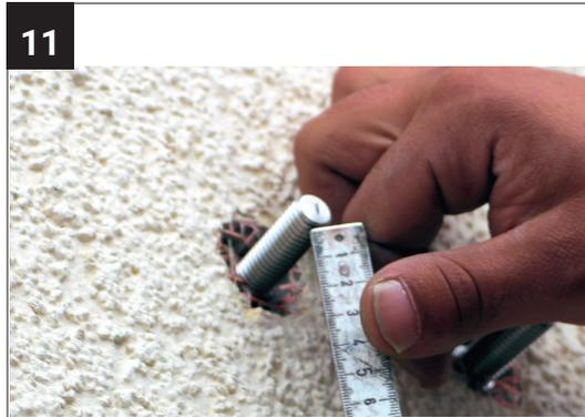
Schieben Sie die Gewindestangen in die Bohrlöcher und testen, ob die Bohrlochtiefe passt. Bohren Sie ansonsten tiefer.
