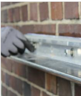
1. Anschrauben der unteren Profilseite
