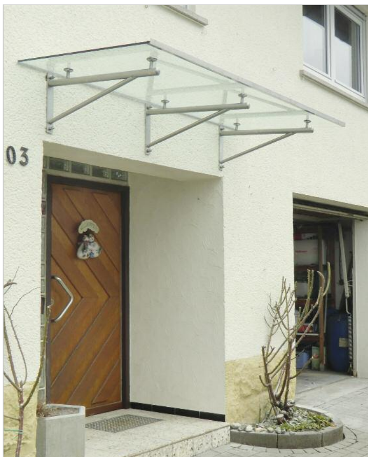
Sonderanfertigung mit Rohrrahmen
