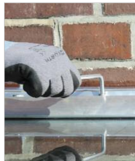
4. Festschrauben der oberen Profilseite
