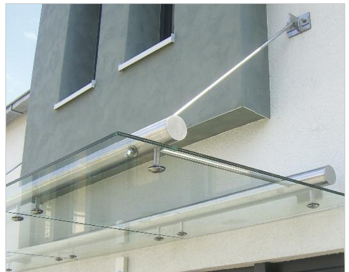
zweiteilige Rohrkonstruktion
