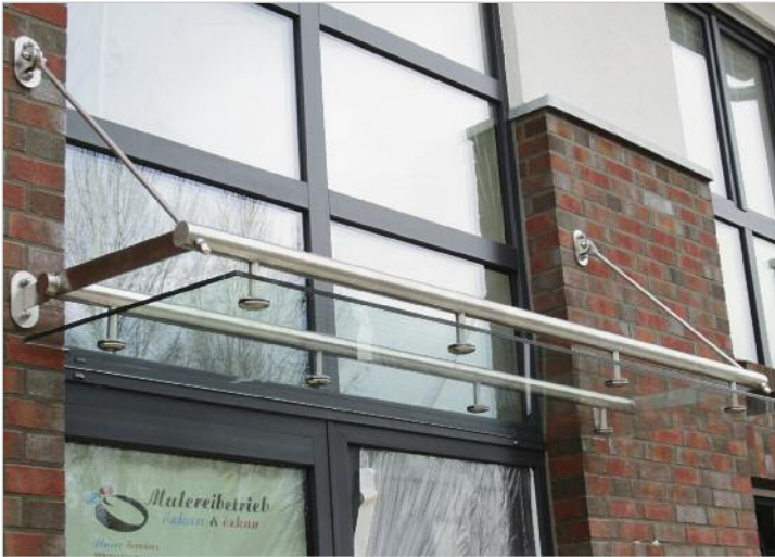
umlaufender Rohrrahmen
