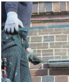
2. Einsetzen der Glasscheibe
