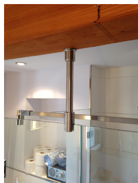
Deckenbefestigung
