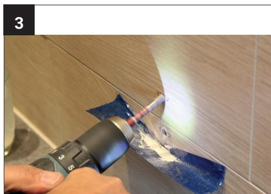
Bohren Sie nun die Löcher in die Wand bzw. in die Decke und saugen dabei den Bohrstaub ab.
