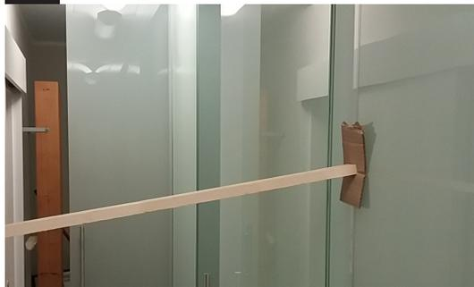
Bei sehr hohen und breiten Gläsern ist eine Fixierung durch Zug oder Druck hilfreich. Beispielsweise mit Holzbalken, die weich abgepolstert werden.
